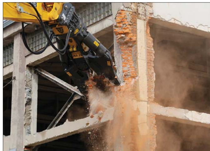
Nożyce serii MA można obracać o 360°, co umożliwia precyzyjne działanie. Układ obrotu z podwójnym łożyskowaniem jest niezwykle odporny na uszkodzenia
