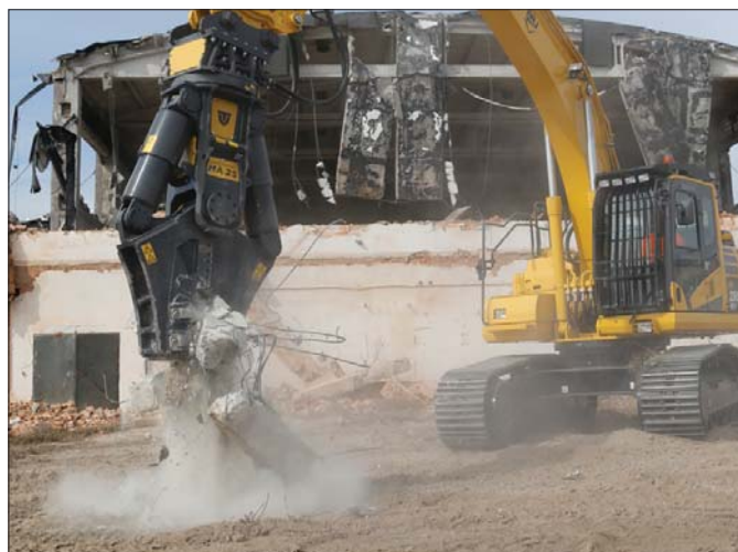
Ważące 2.700 kilogramów nożyce Trevi Benne MA 25 sprawdzają się doskonale nawet podczas pracy w najtrudniejszych warunkach
